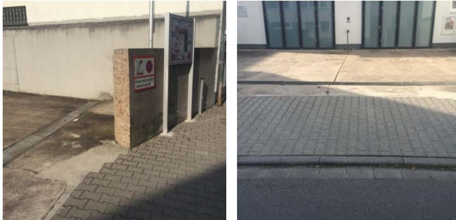
Abb. 7\_Ablauf als Oberflächenentwässerung des Stauraums vor dem Gerätehaus
